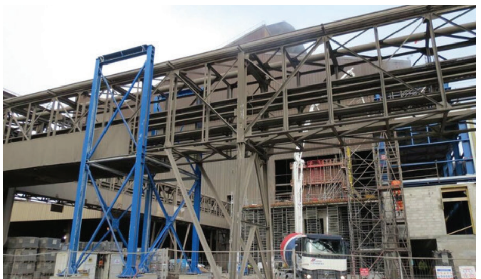
Four poche ArcelorMittal Fos sur mer.
